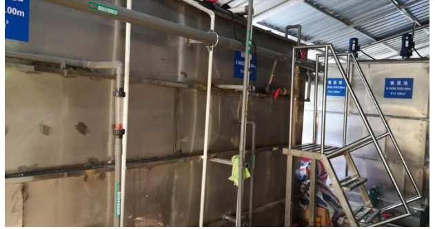
废水站主体水池
